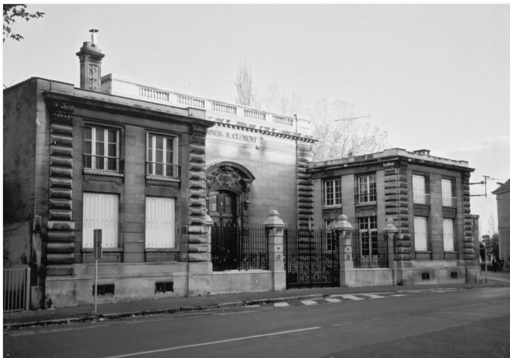
Vue des turbines A. Clément.
